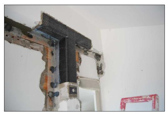
Fasciatura in fibra di carbonio con prova di strappo
