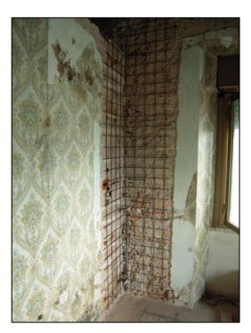
Rinforzo strutturale di muratura con applicazione interna ed esterna di rete elettrosaldata
