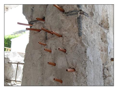
Iniezioni di resine epossidiche per consolidamento preliminare del calcestruzzo per applicazioni di fibra di carbonio
